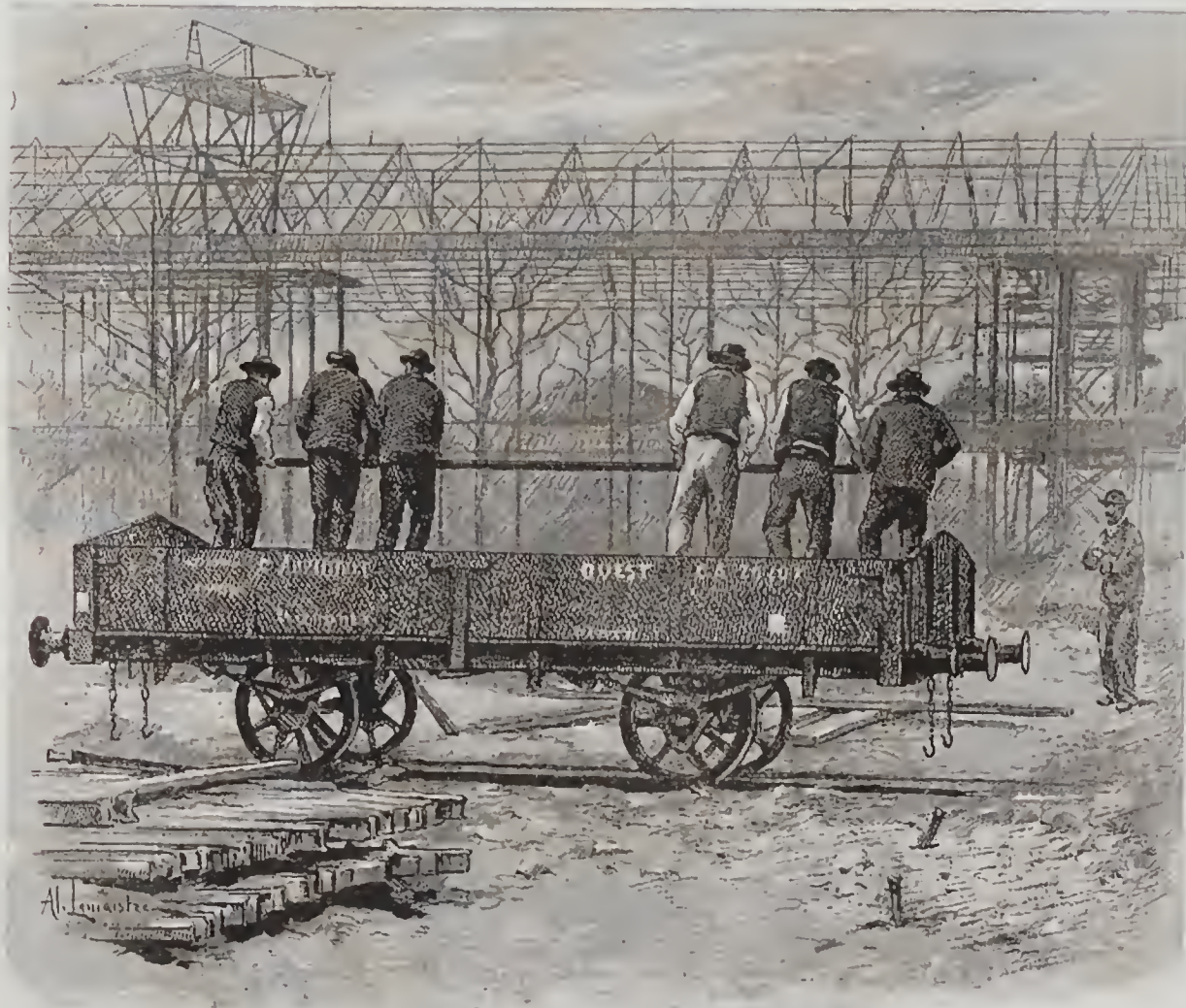
SUR LES CHANTIERS. — Déchargement des rails pour l'établissement des voies ferrées du Champ-de-Mars.
